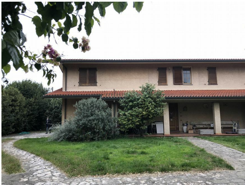
Descrizione: Vialetti interni
