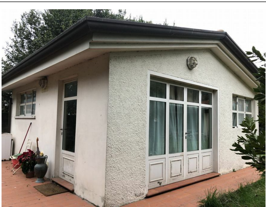
Descrizione: Fabbricato accessorio esterno lato nord-est
