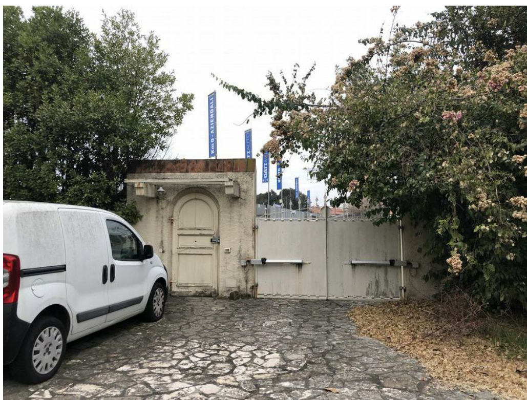
Descrizione: Cancelli di ingresso
