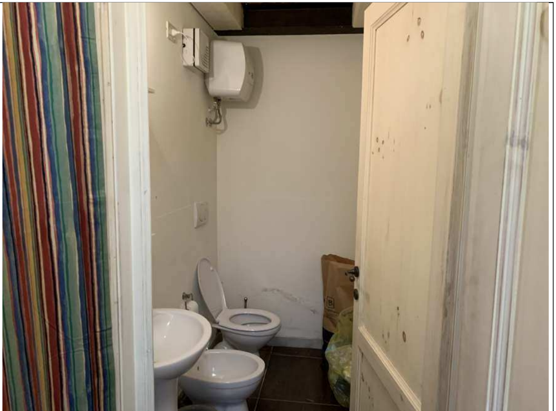
Descrizione: Vista del servizio igienico.
